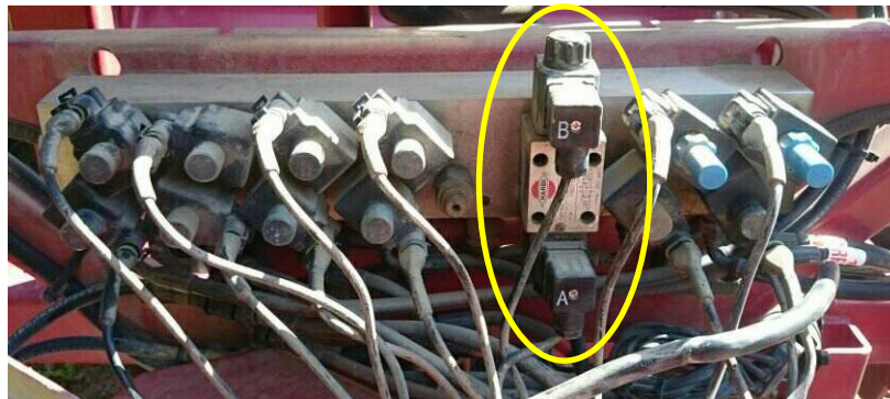
Bild B, Ventilblock med Flödesriktningventil markerad
